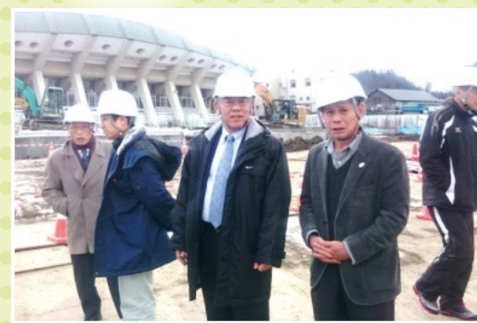
建設中の新体育館を市体育協会で視察
